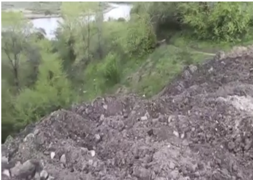
Рис. 2. Оползневый склон укрепленный боем каменных строительных материалов
