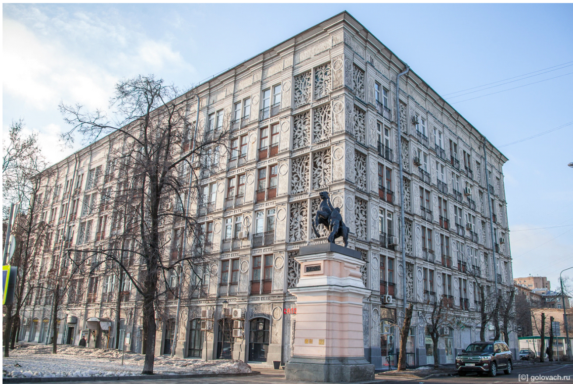
Рис. 2. Знаменитый панельный «Ажурный дом» в Москве на Ленинградском проспекте, 27, архитекторы А.К. Буров и Б.Н. Блохин, 1941 - год завершения строительства
