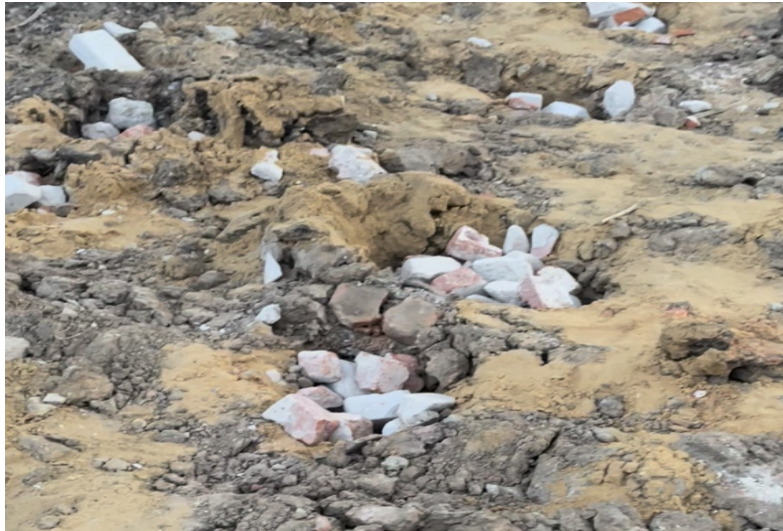
Рис. 4. Засыпка боем кирпича
