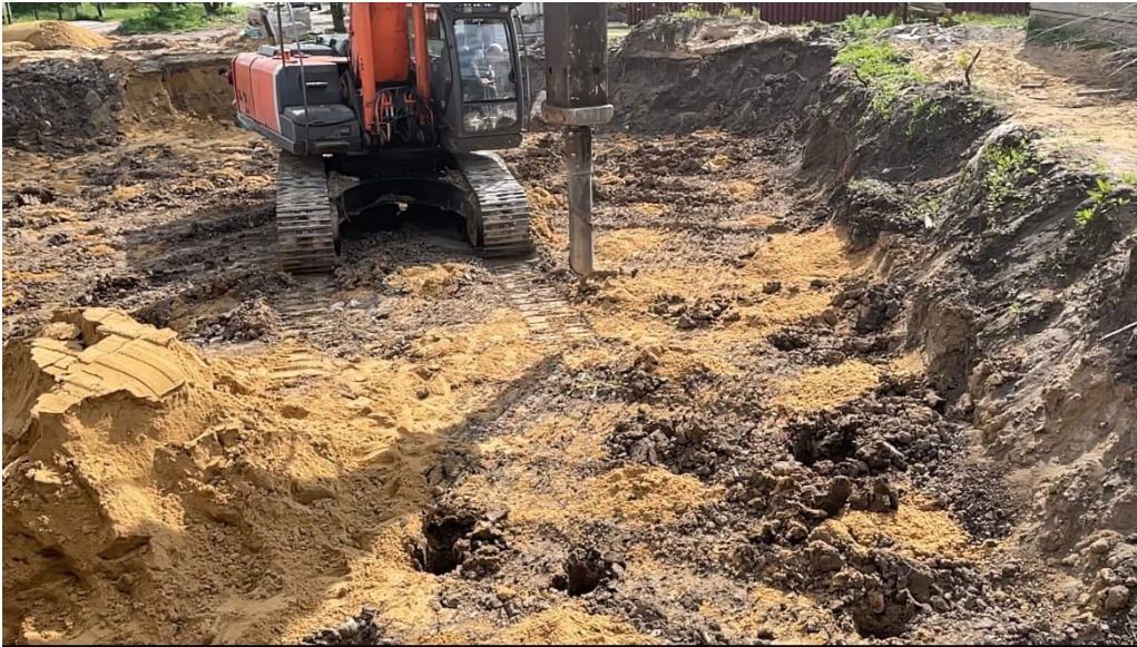
Рис. 2. Выштамповка микросвай на строительном объекте
