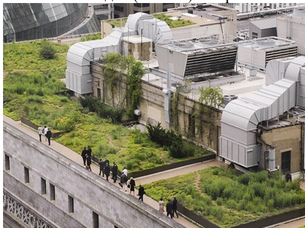
Рис. 4. Эксплуатируемая кровля в Чикаго
