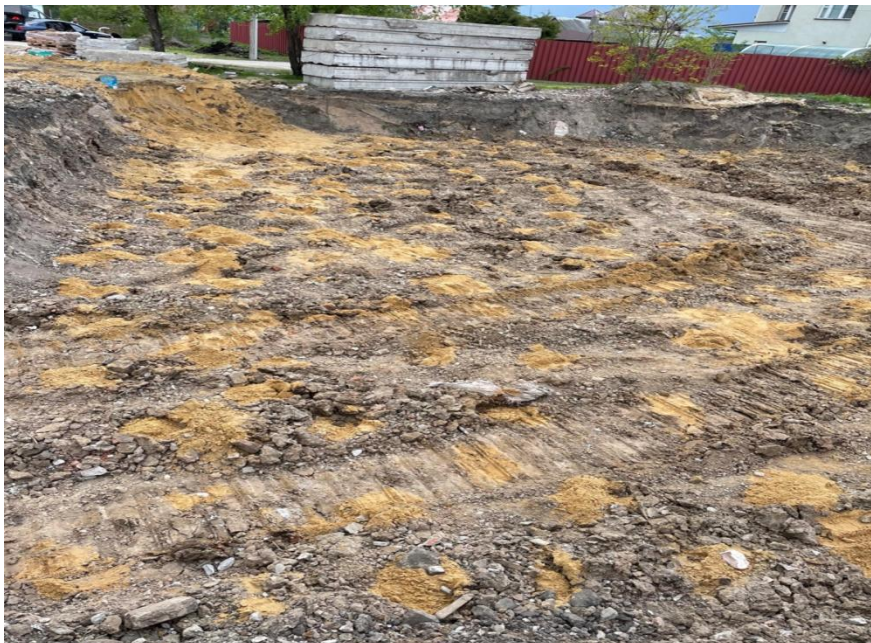
Рис. 3. Заполнение микросвай песком
