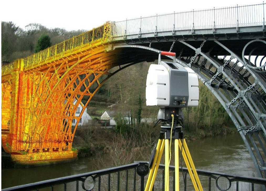
Рис. 1. Лазерное сканирование конструкций моста
