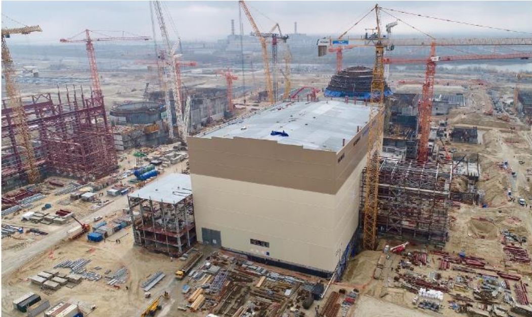
Рис. 1. Применяемые краны при строительстве АЭС Курск-2
