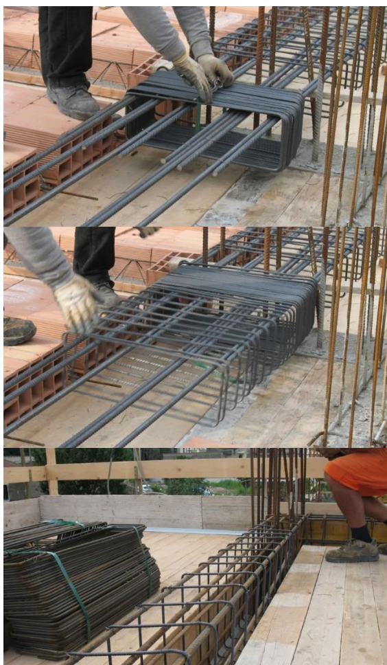
Рис. 2. Пример монтажа непрерывных хомутов спиралей, выполненных по технологии «Spirex»
