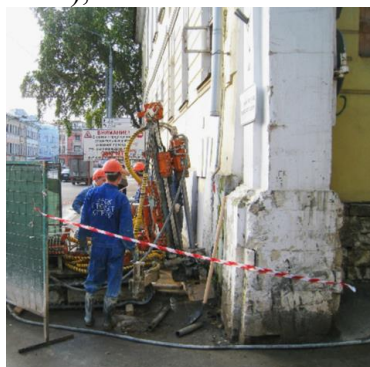
Рис. 2. Реставрация исторических зданий «Екатерининской больницы» [4]
