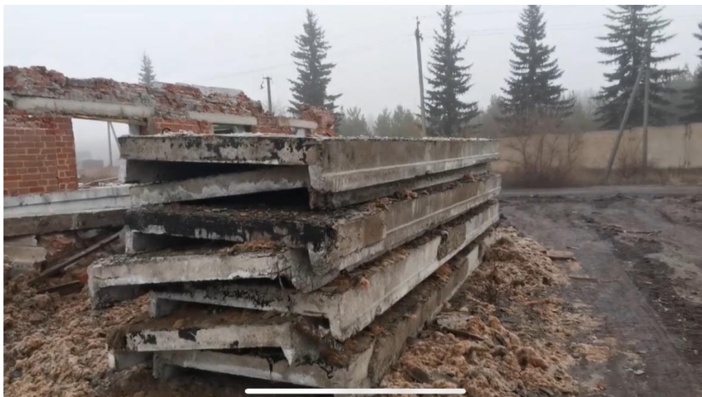
Рис. 3. Б/У плиты при поэлементном демонтаже здания
