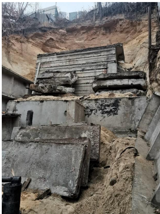
Рис. 4. Процесс укладки плит в фундамент
