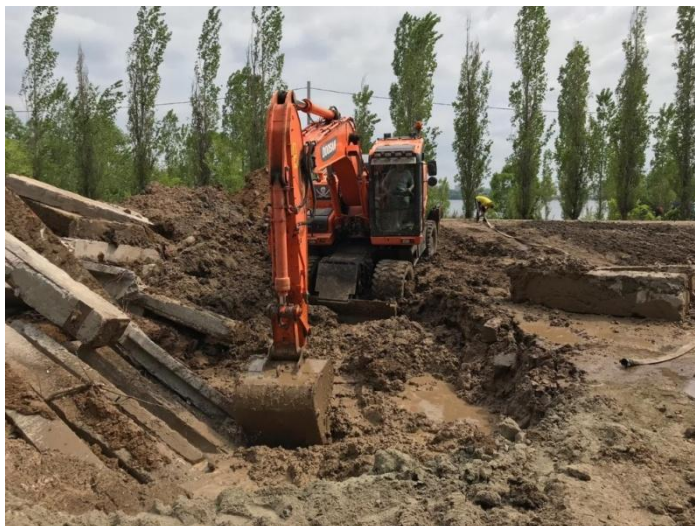
Рис. 3. Замешивание глинистого грунта с подземными водами
