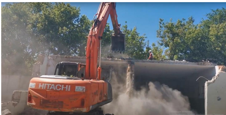
Рис. 5. Поэлементный демонтаж здания
