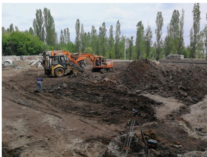
Рис. 2. Рытье котлована до глинистых грунтов
