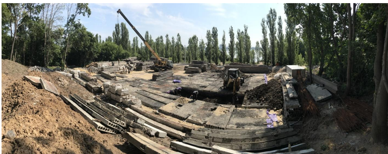
Рис. 13. Общий вид строительной площадки
