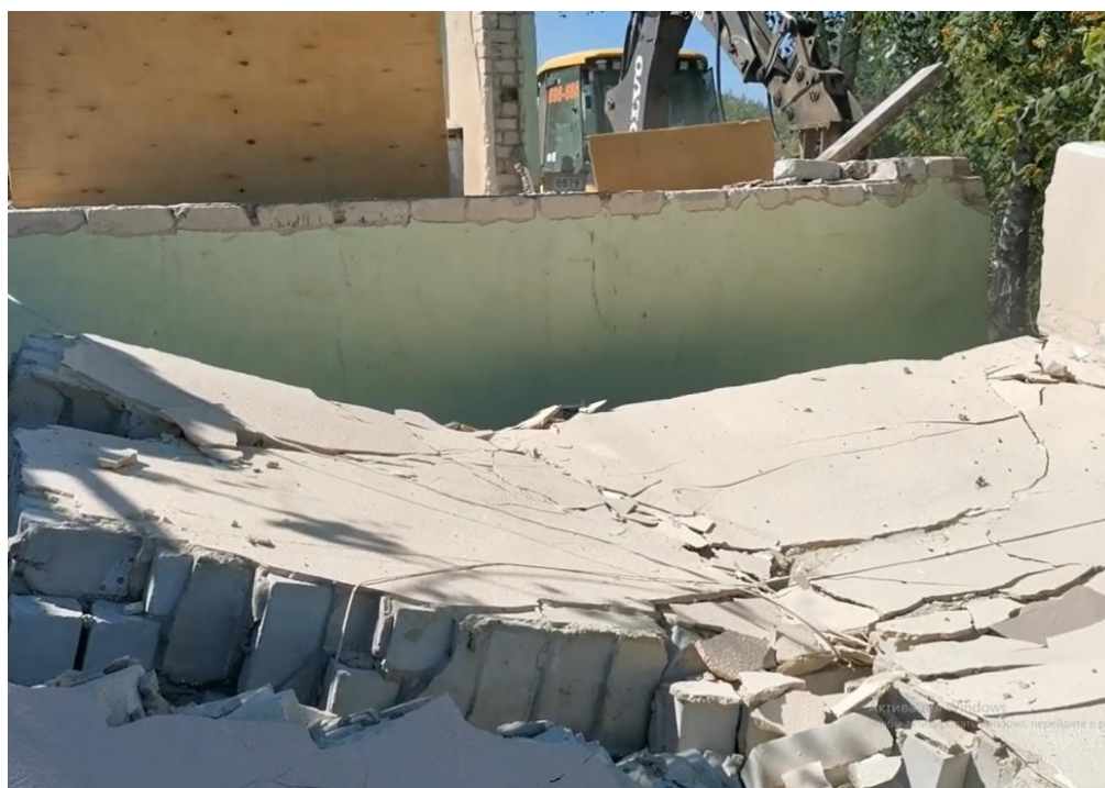
Рис. 6. Поэлементный демонтаж здания
