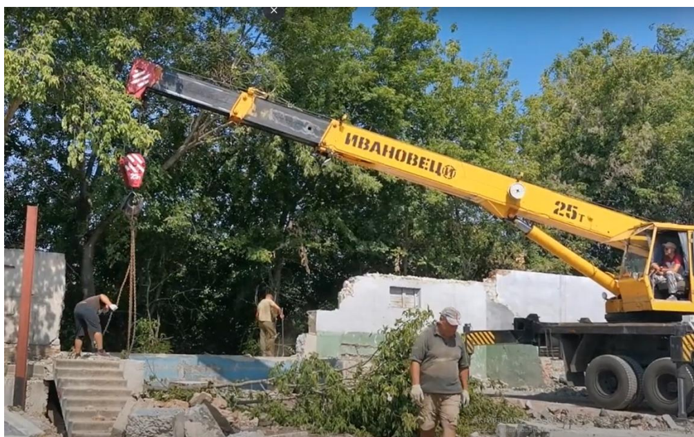
Рис. 6. Поэлементный демонтаж здания
