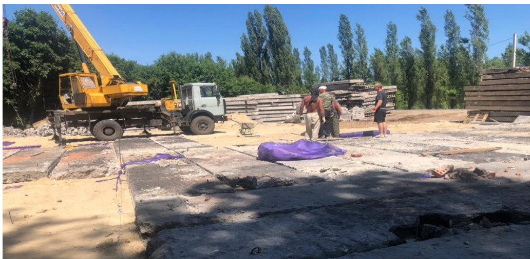
Рис. 12. Повторное использование ж/б плит в качестве плитных конструкций фундаментов
